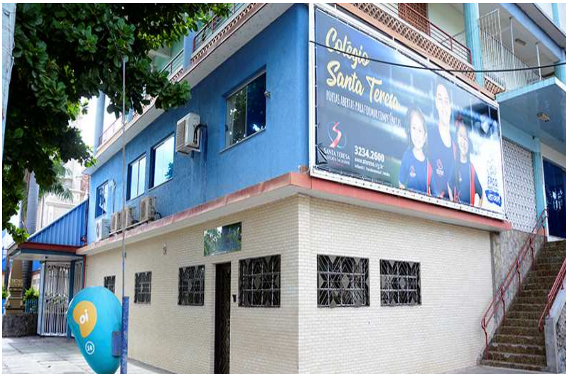
Figura 7 - Fachada do NUPRAJUR – localizado na esquina da rua Dom Aquino (que dá acesso à Bolívia) e rua 15 de Novembro. Fonte Diário Online
