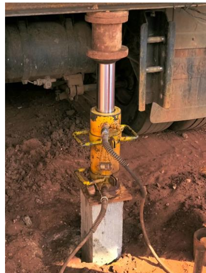
Figura 1 – Estaca prensada reagindo contra estrutura. Fonte: Autor
