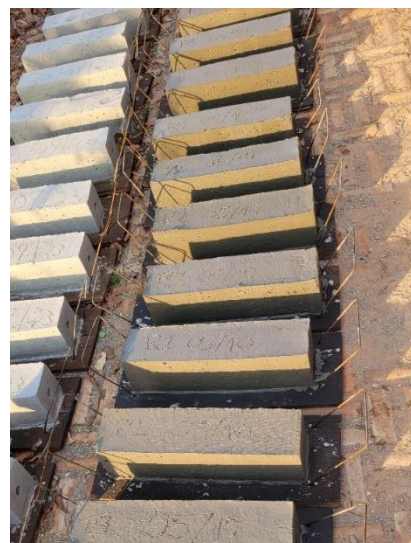
Figura 9 – Segmentos moldados de estacas prensadas. Fonte: Autor
