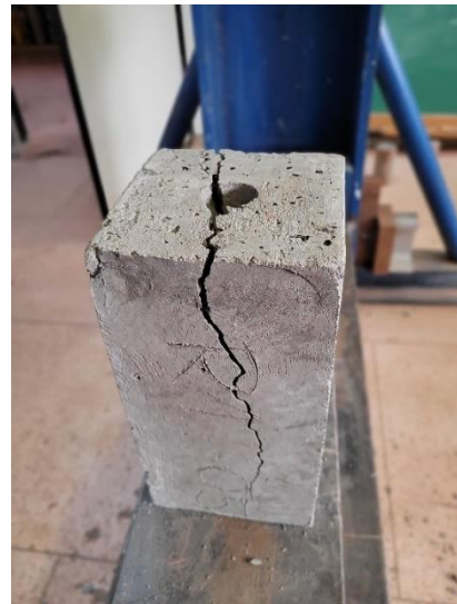
Figura 27 – Fissuras originadas nas juntas dos segmentos descontínuos. Fonte: Autor
