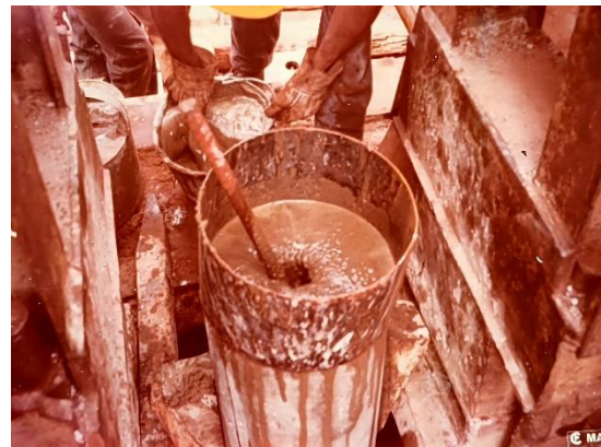
Figura 4 – Preparação das juntas nas estacas Mega. Fonte: London, 1984.
