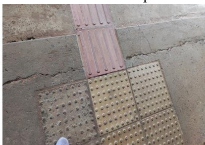
Figura 5: saída do bloco 1 para o bloco 4.
