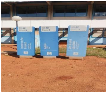
Figura 14: fachada de entrada para o bloco 3, sem sinalização.
