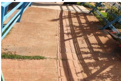
Figura 29: rampa de acesso para a entrada da biblioteca.
