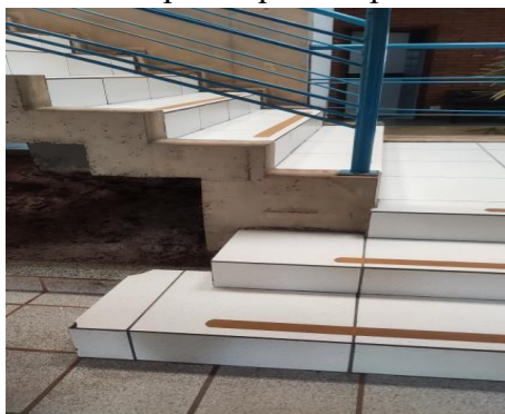
Figura 15: Escada para a parte superior do bloco 3.
