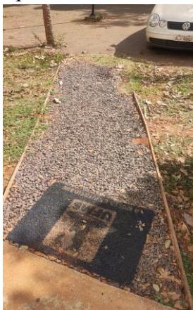
Figura 30: rampa de acesso lateral da biblioteca.
