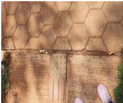
Figura 28: início de acesso à rampa para entrada da biblioteca.
