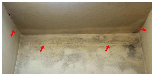
Figura 18 – Fissuração por movimentação térmica da laje de cobertura sobre paredes autoportantes.
