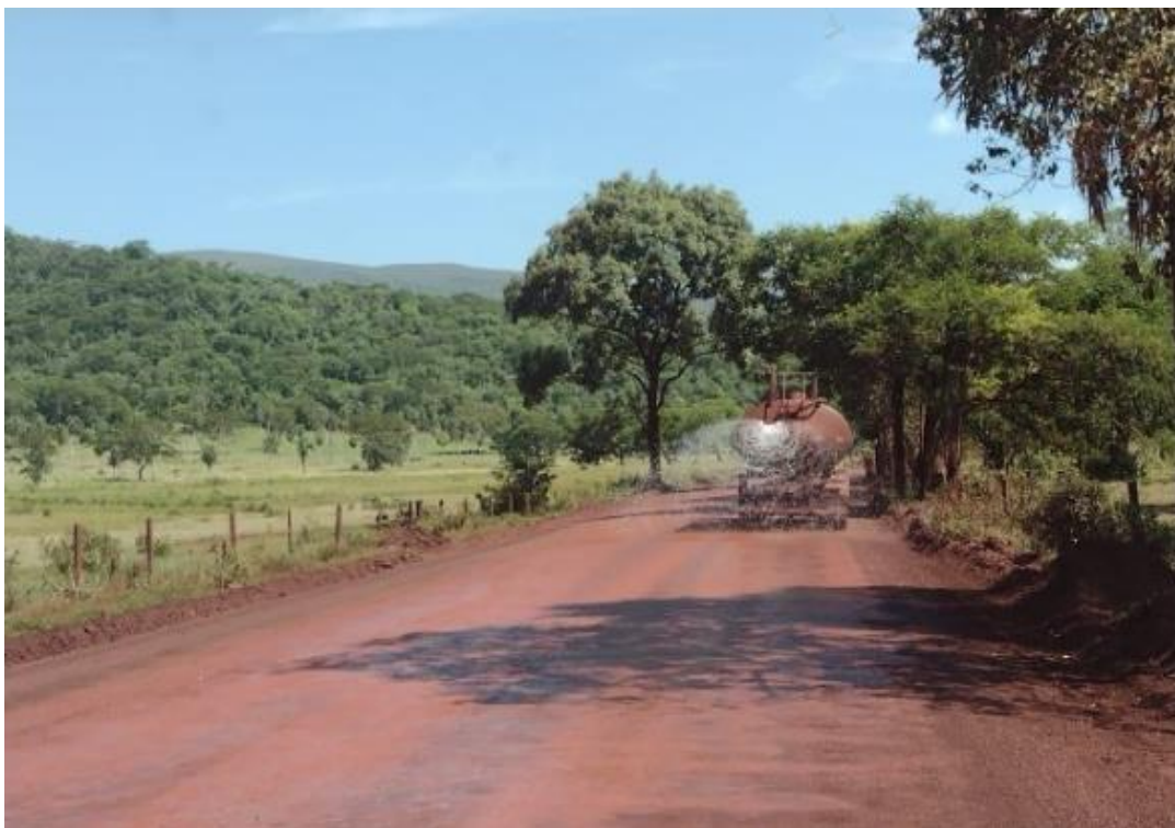
Figura 7. Umectação da via externa das mineradoras.
