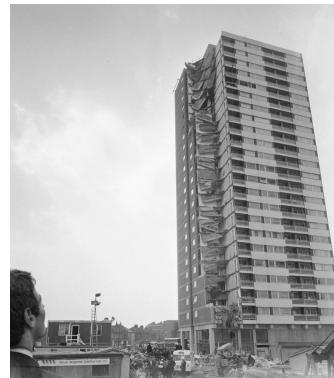
Figura 1 – Colapso do edifício Ronan Point.
