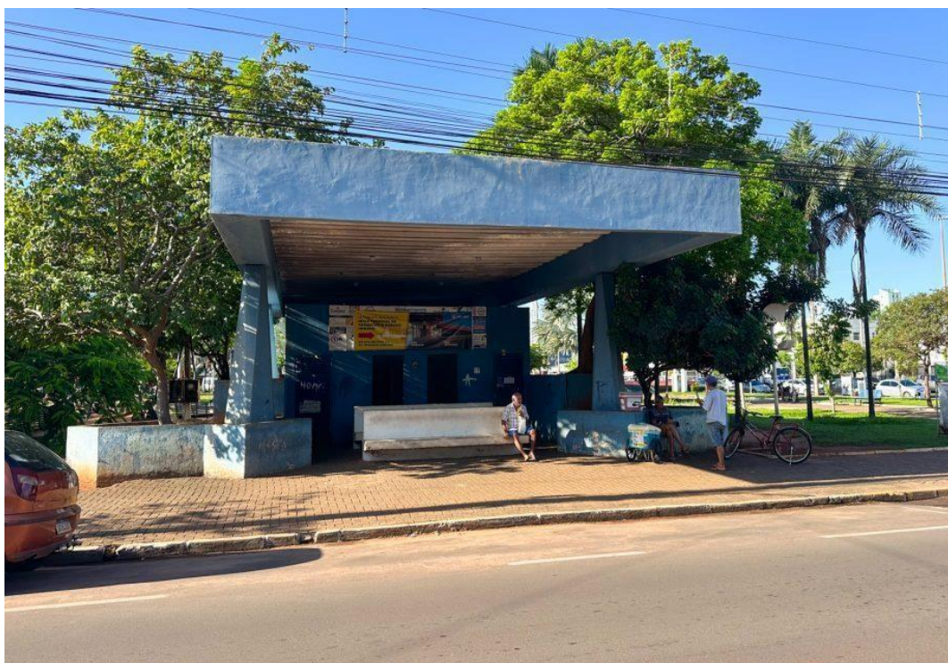
Figura 5 – Terminal de ônibus praça Ramez Tebet
