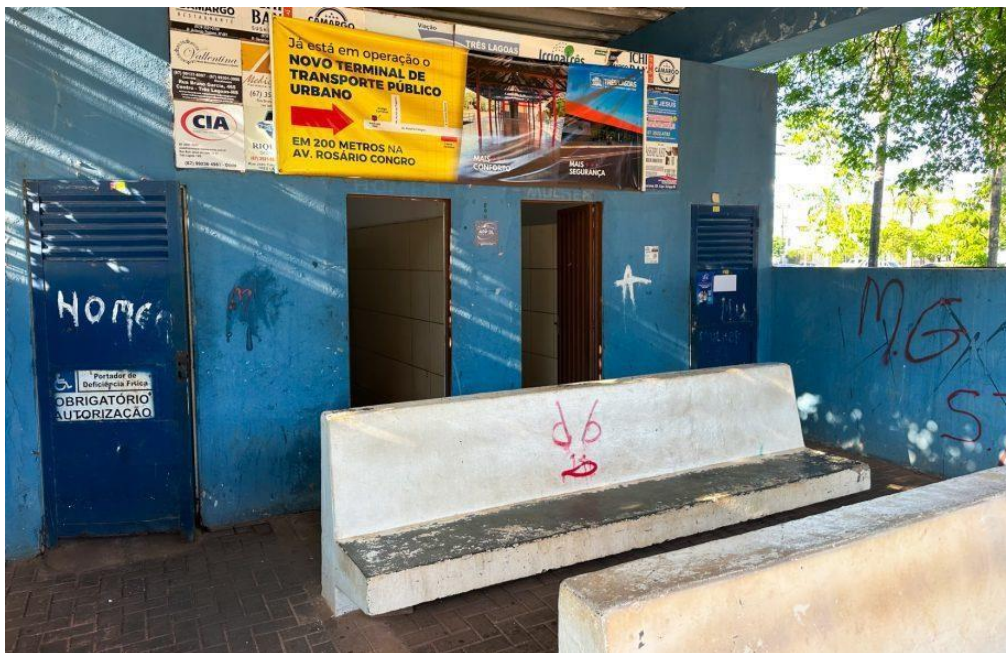
Figura 7 – Banheiros na praça Ramez Tebet
