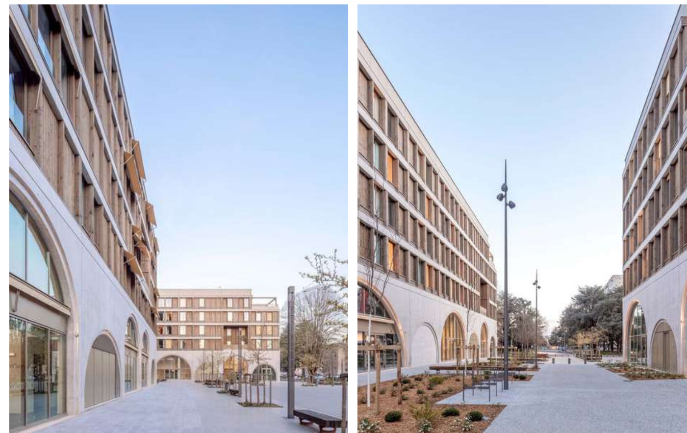
Fig: 55 - Imagens Pátio externo do Centro Laherrère
