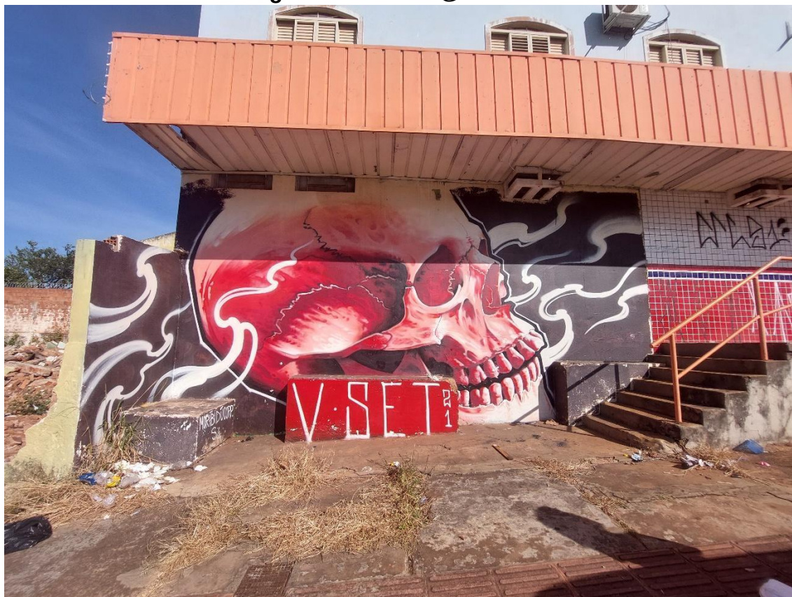
Rua General Osório, Bairro Amambai – parede de prédio comercial – 14/07/2022, 9h15
