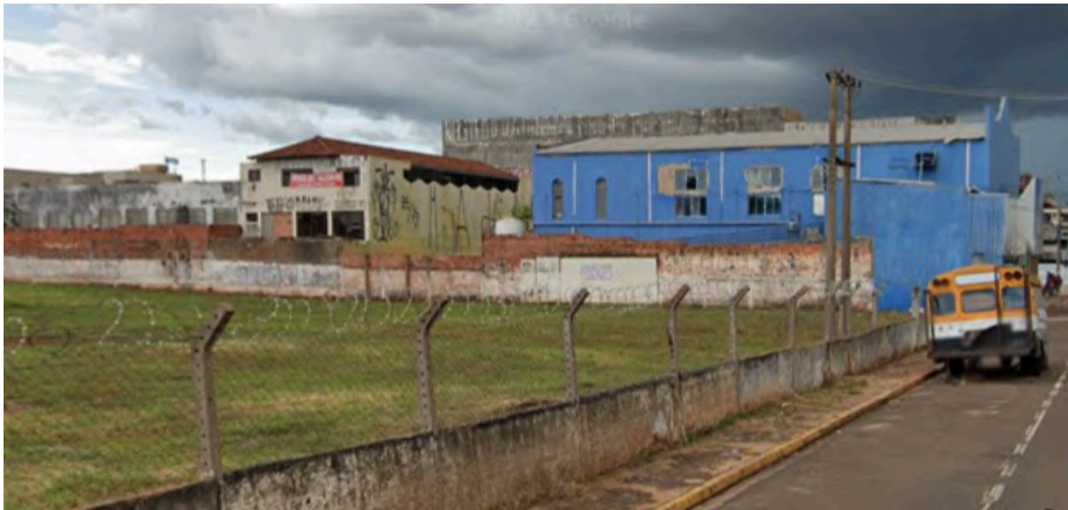
Figura 95 - Rua Vasconcelos sem postes de iluminação para pedestres
