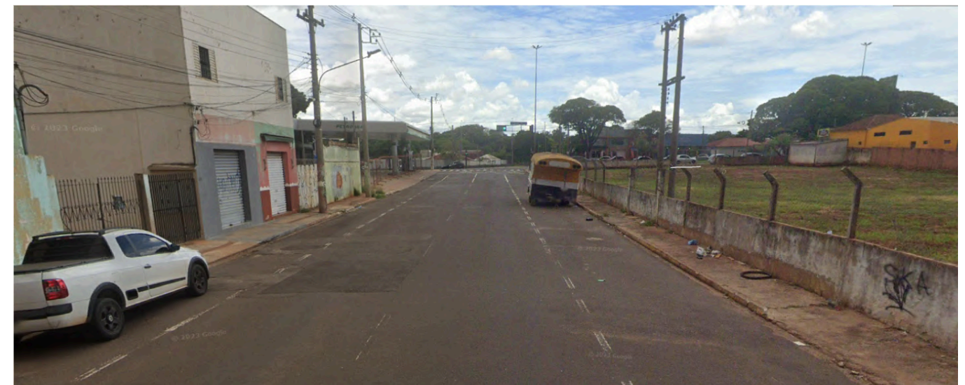
Figura 101 – Situação da Rua Vasconcelos Fernandes.
