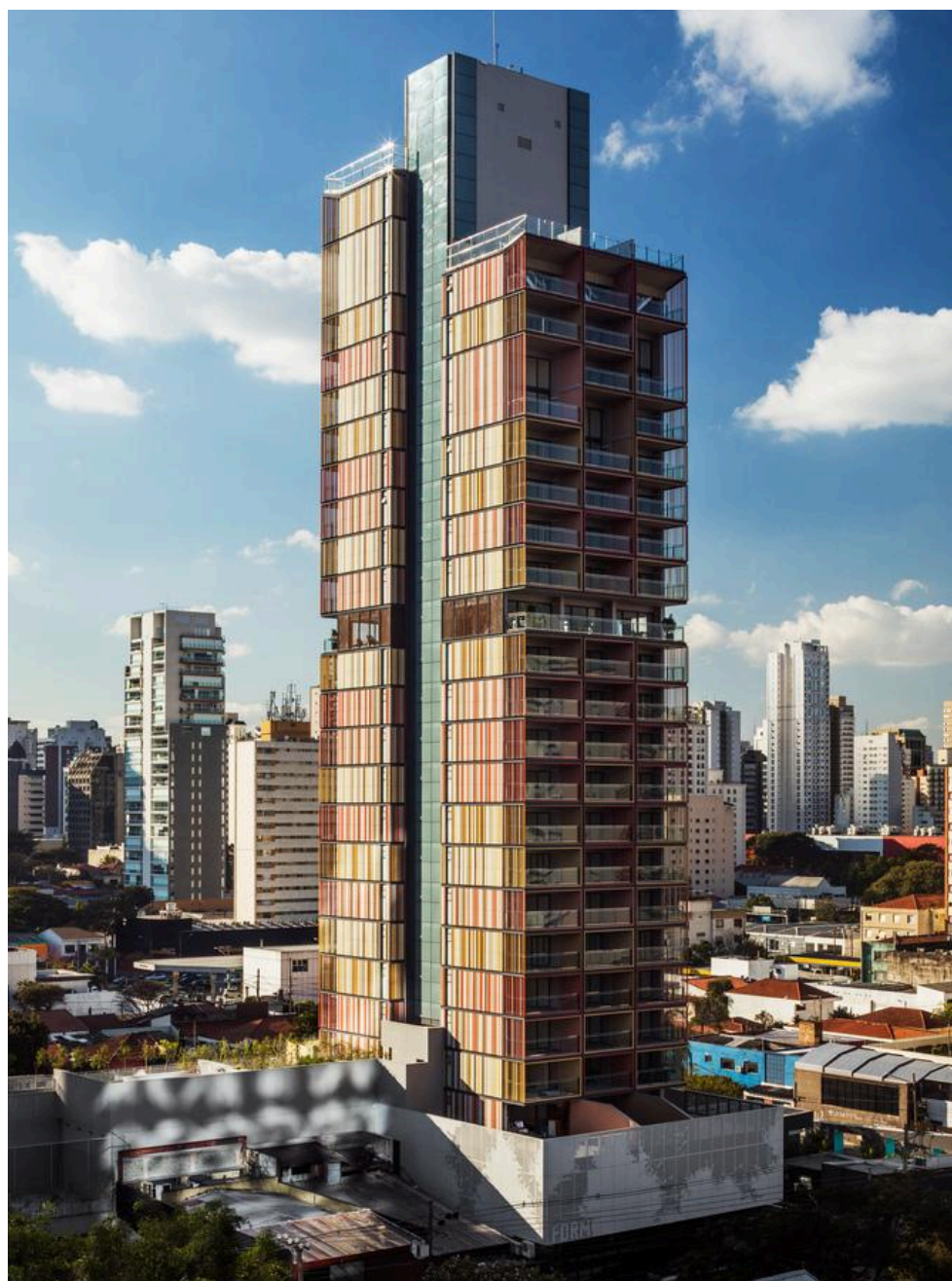
Figura 56 – Volumetria do edifício Torre Forma Itaim
