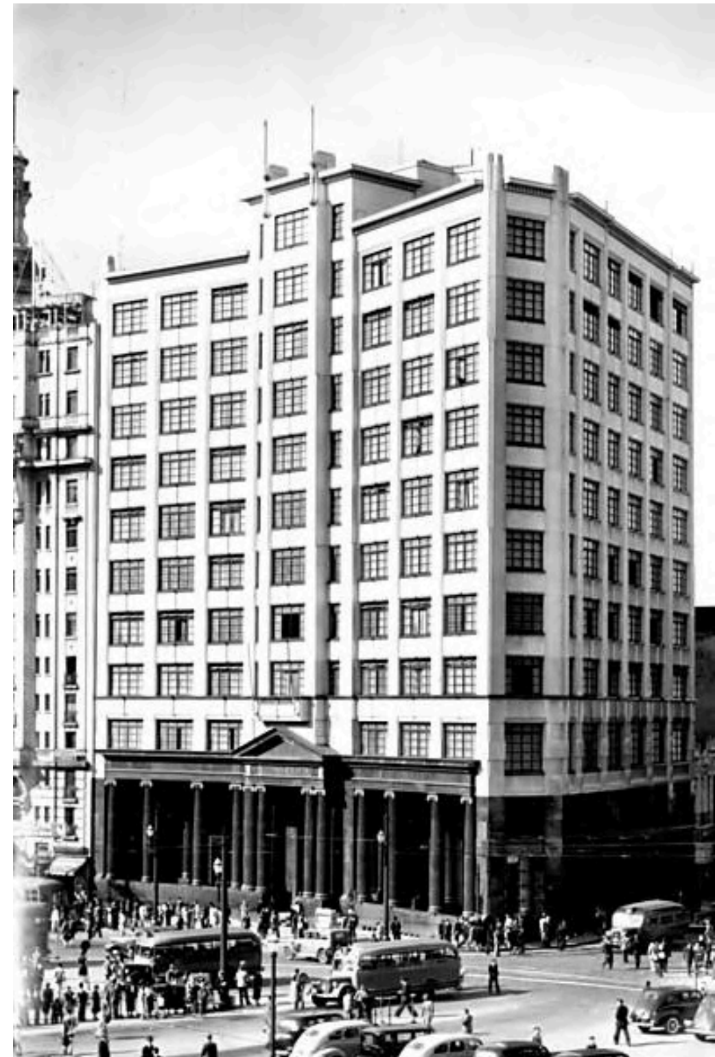
Figura 32 – Edifício Sé, São Paulo, 1940
