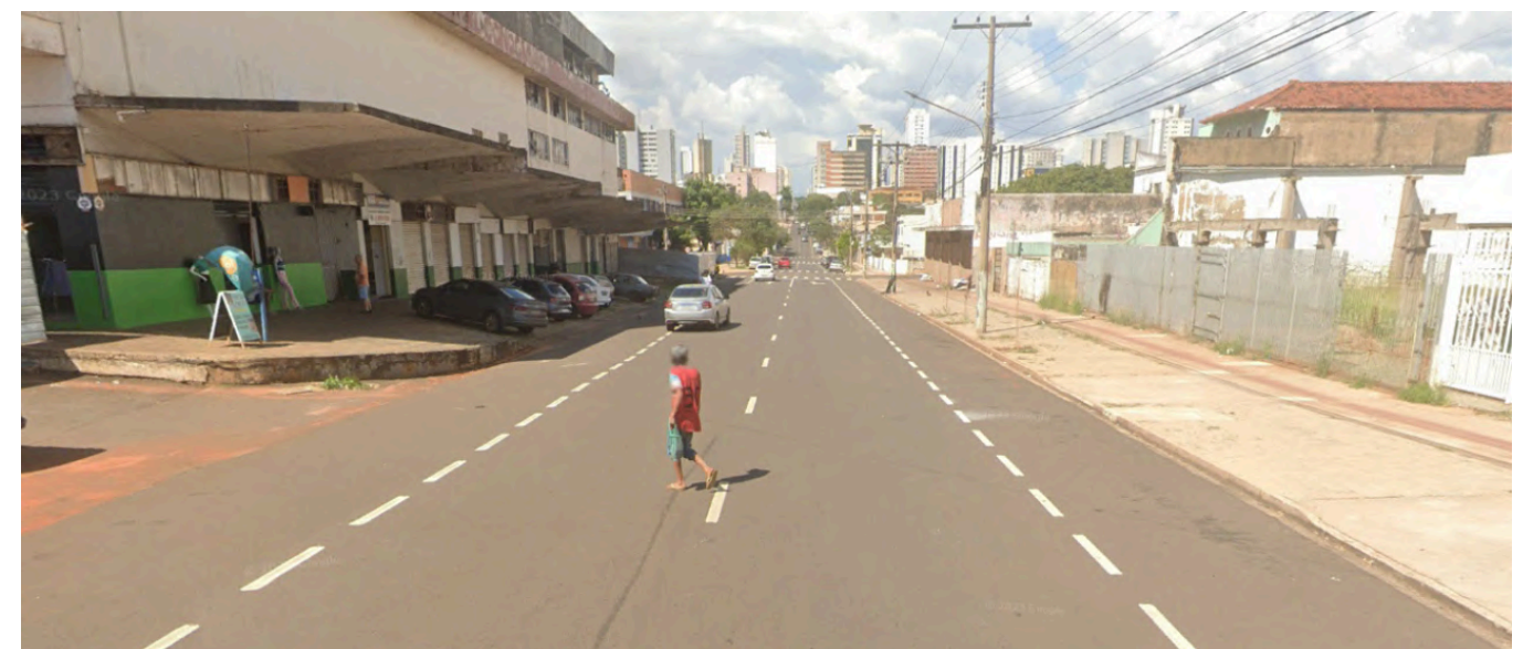
Figura 102 – Situação da Rua Barão do Rio Branco
