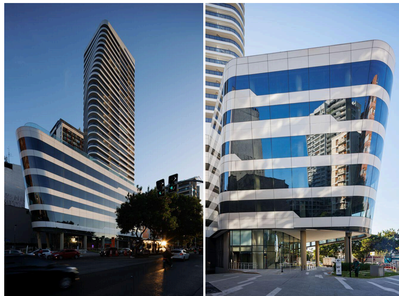
Figura 18 – Edifício White 2880, em São Paulo, evidenciando fachada ativa
