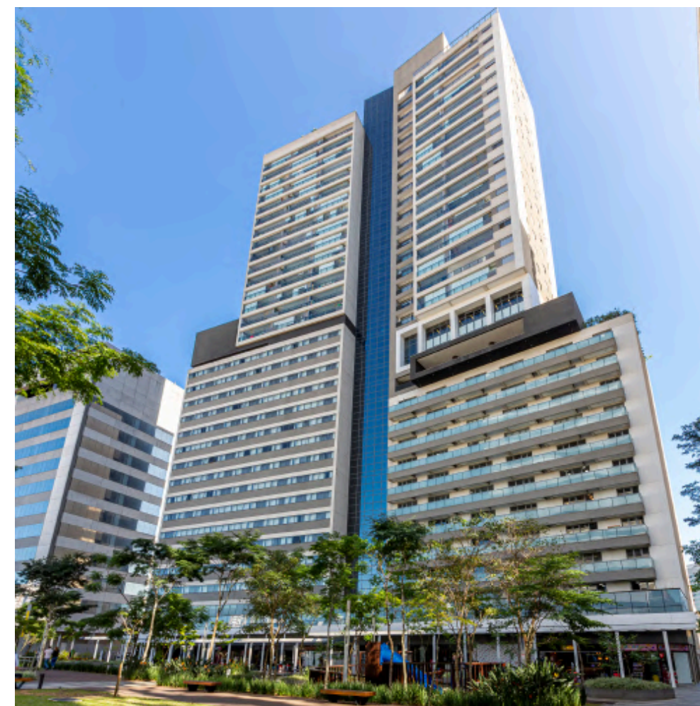
Figura 34 – Edifício Praça São Paulo
