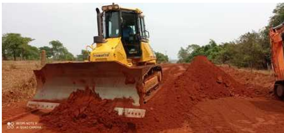
Imagem 10: Maquinário atuando na manutenção da estrada principal do assentamento (2021) Fonte: Acervo Nova Andradina (2021)
