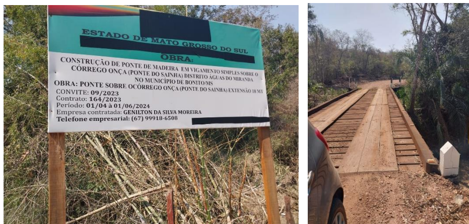
Figura 12: Ponte do Sainha (Córrego da Onça), distrito de Águas do Miranda
