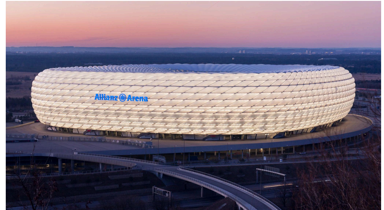
Figura 20 - Estádio Allianz Arena (Alemanha).
