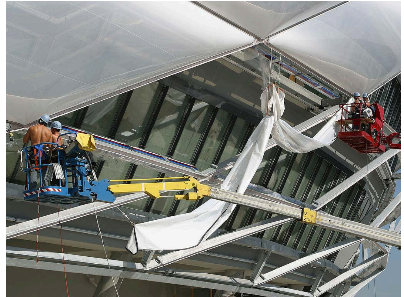
Figura 36 - Instalação de membranas de ETFE
