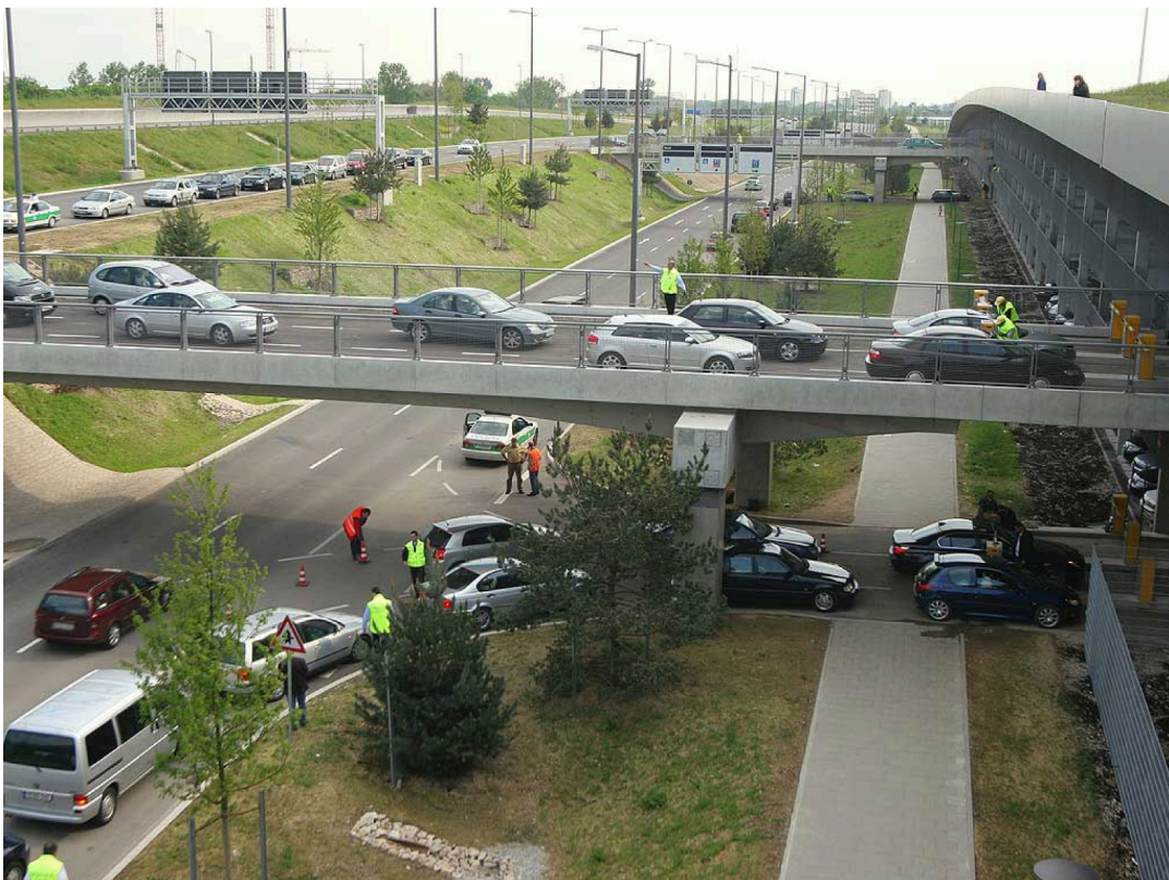
Figura 40 - Entrada do estacionamento do estádio
