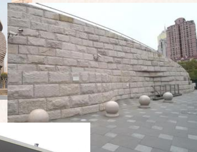
Figura_35 - Fachada de pedra ao norte
