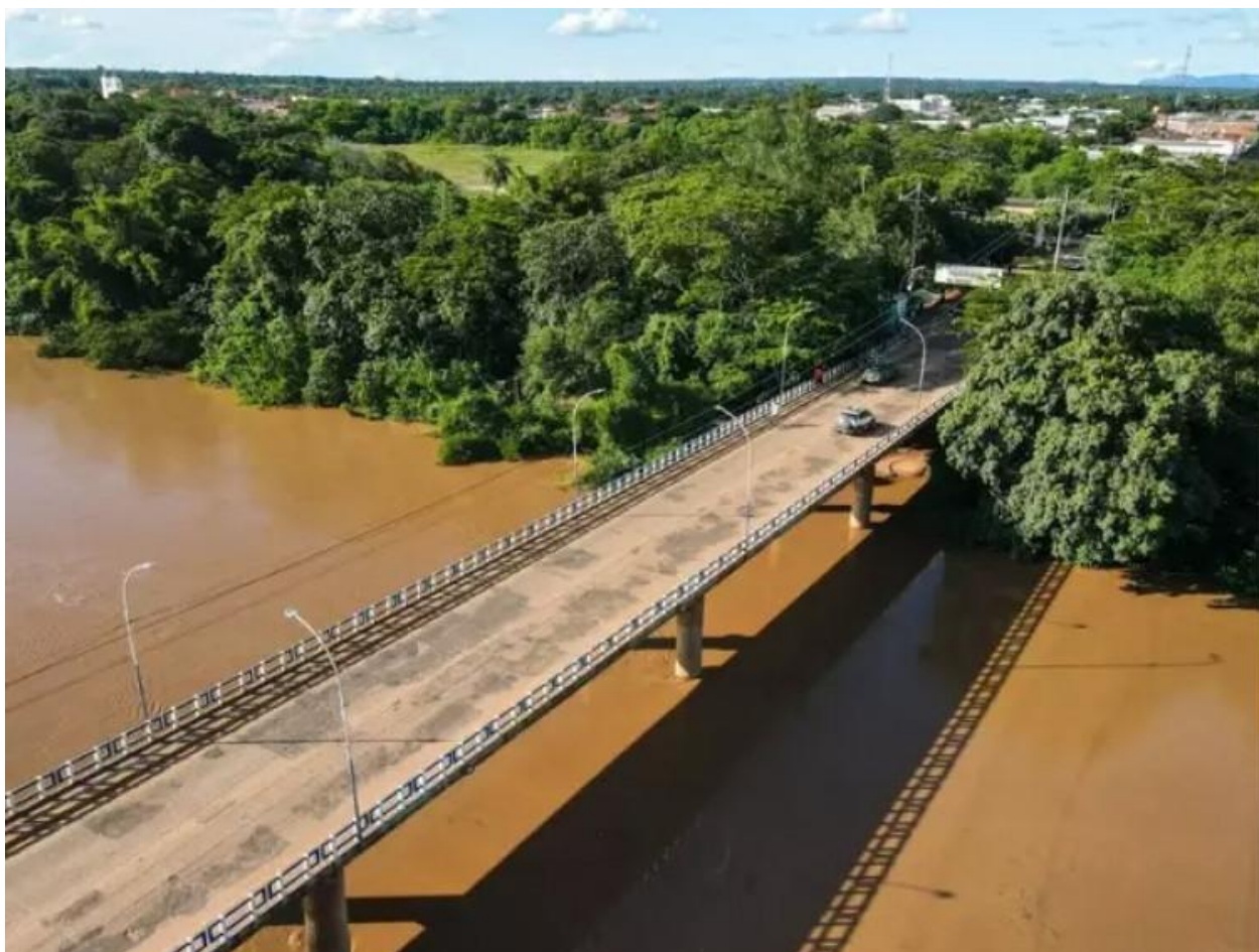
Figura 3. Ponte Roldão de Oliveira, em Aquidauana/MS.
