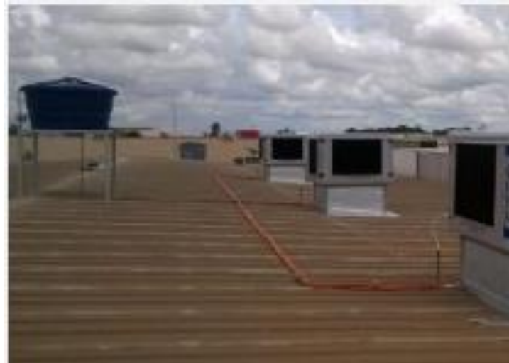
Figura 9 - Instalação de um climatizador de teto Ecoclimas
