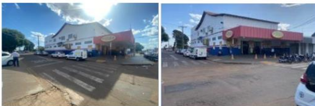
Figura 35 - Vista da fachada da loja Piratininga
