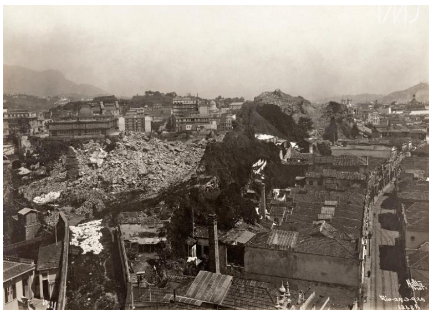
Fig. 36: Instituto Moreira Sales. Demolição do Morro do Castelo Rio de Janeiro, 23 de março de 1925.
