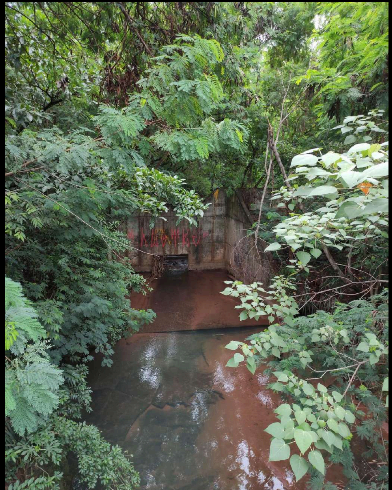
Figura 43 - Barragem no córrego Sóter / Acervo pessoal
