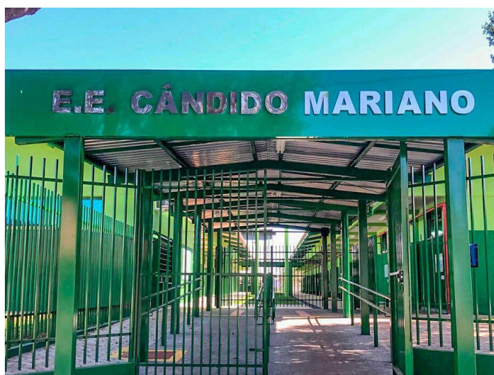
FIGURA 3 – REFORMA DA ESCOLA ESTADUAL CÂNDIDO MARIANO
