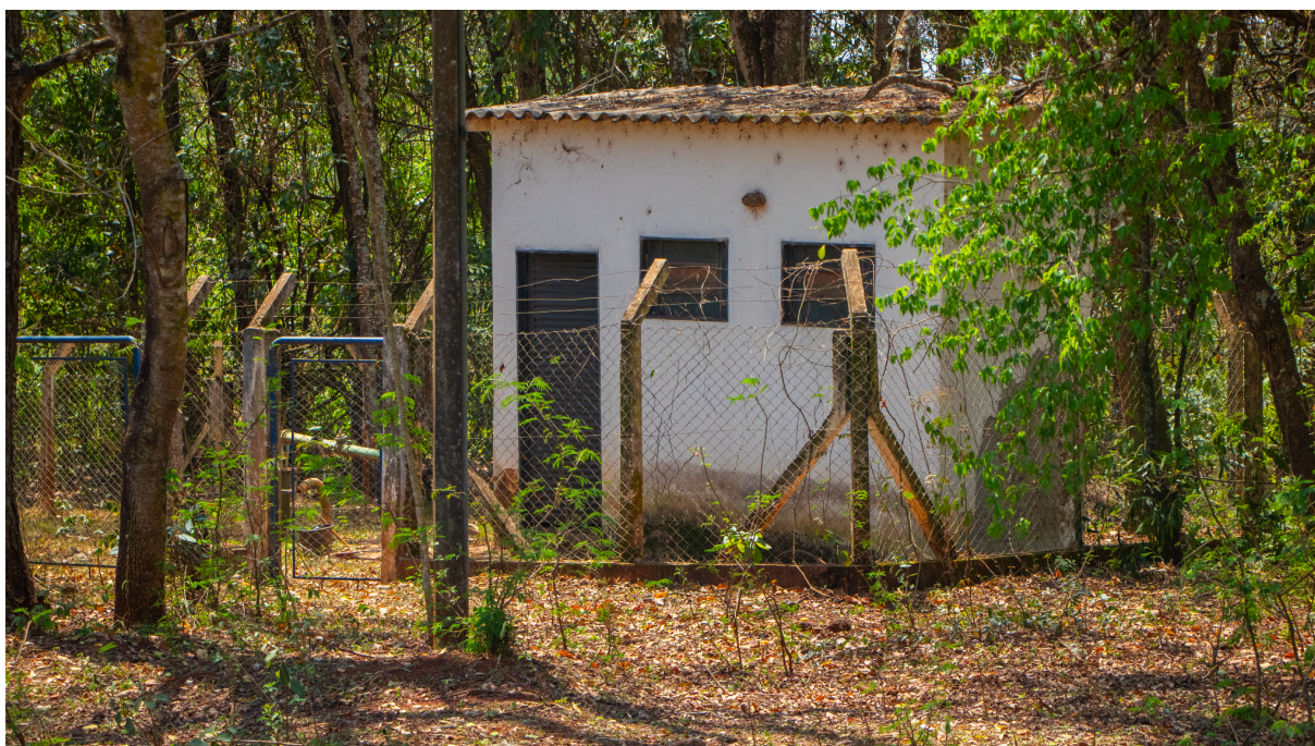
Figura 1 – foto do poço na casa do entrevistado Elizeu.
