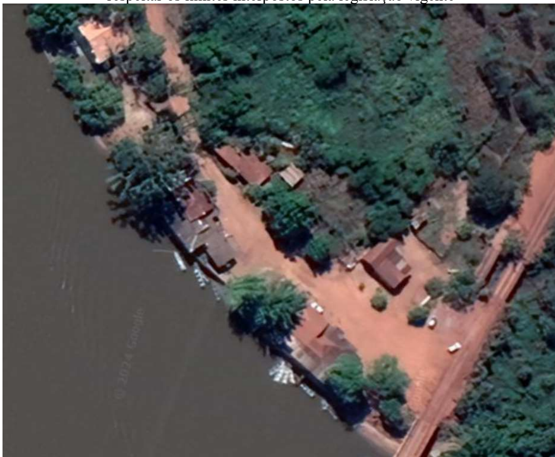
Figura 5 – Imagem do Google Earth, construções em Área de Preservação Permanente, sem respeitar os limites interpostos pela legislação vigente
