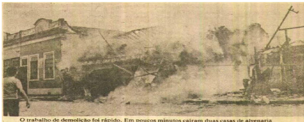
Figura 21 - Demolição de casas da Zona do Mangue. Lampião da Esquina , ed. n.7, 1978, p.3.
