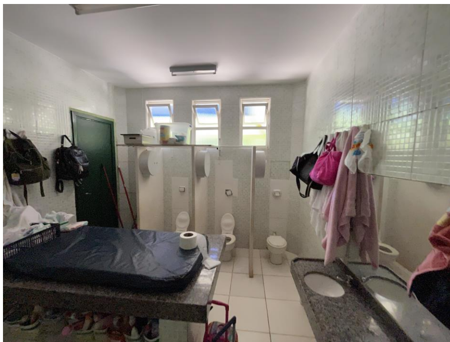
Figura 13: Banheiro – Centro de Educação Infantil ZEDU
