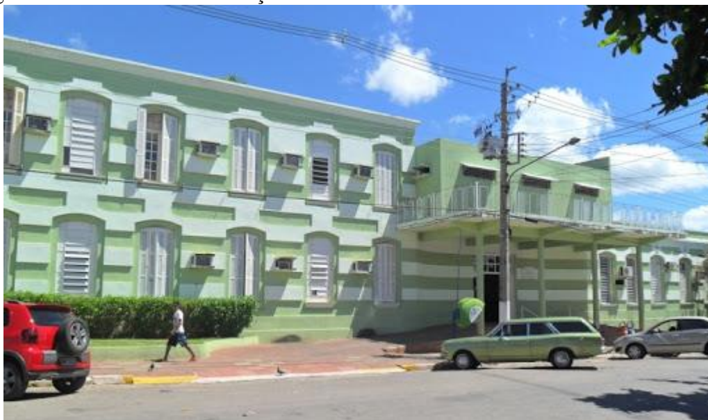
Figura 20 - Fachada da Associação Beneficente de Corumbá - Santa Casa de Corumbá
