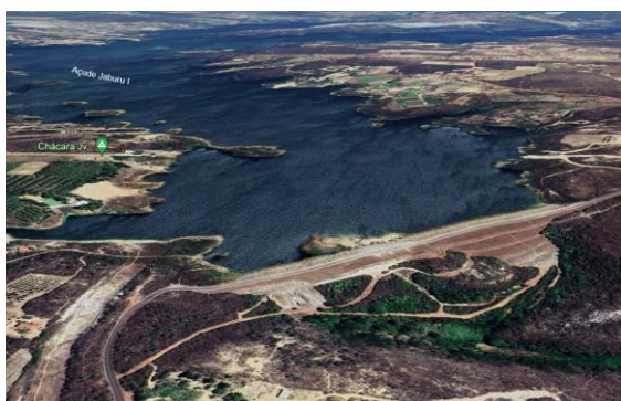
Figura 4 - Reservatório Jaburu 1, 3°51'53"S 41°06'53"W. Google Earth, 2023.
