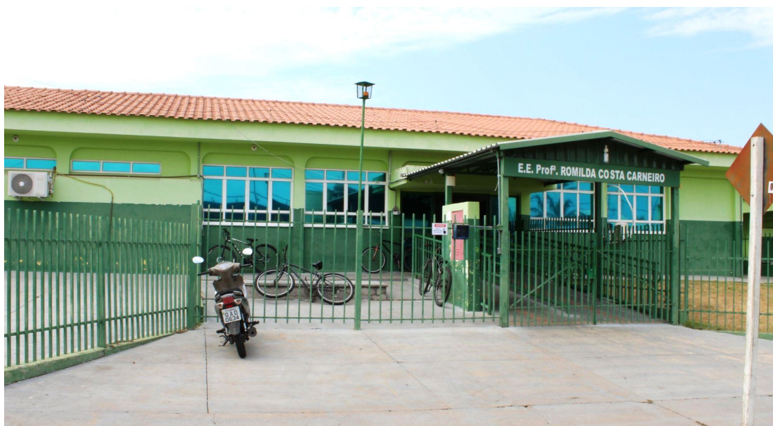
Figura 5: Foto da escola estadual Romilda Costa Carneiro
