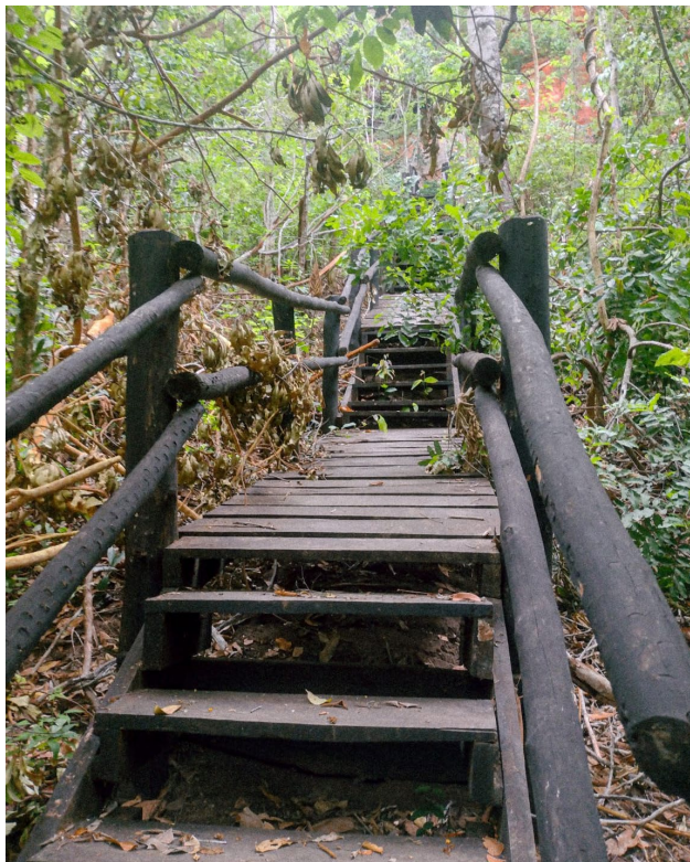
Figura 19: Passarela de madeira da Gruta do Pitoco
