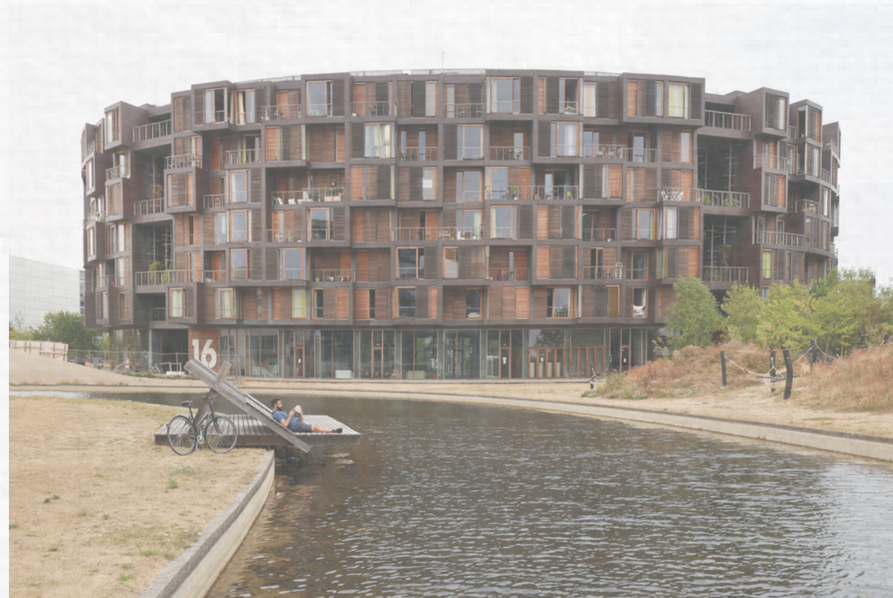
Figura 06 - Fachada principal do bloco 1
