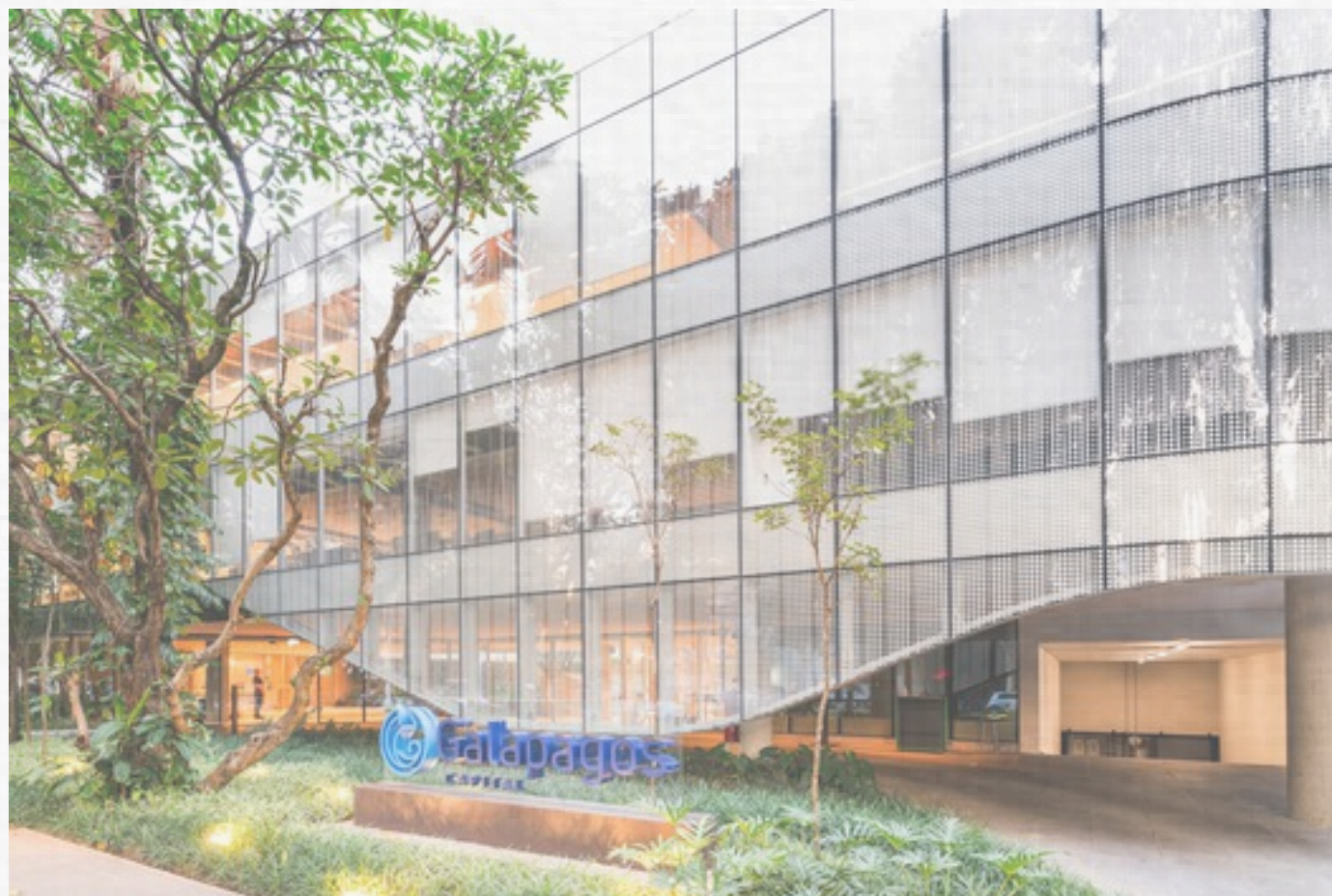
Figura: 17 - Fachada do Galapagos Capital
