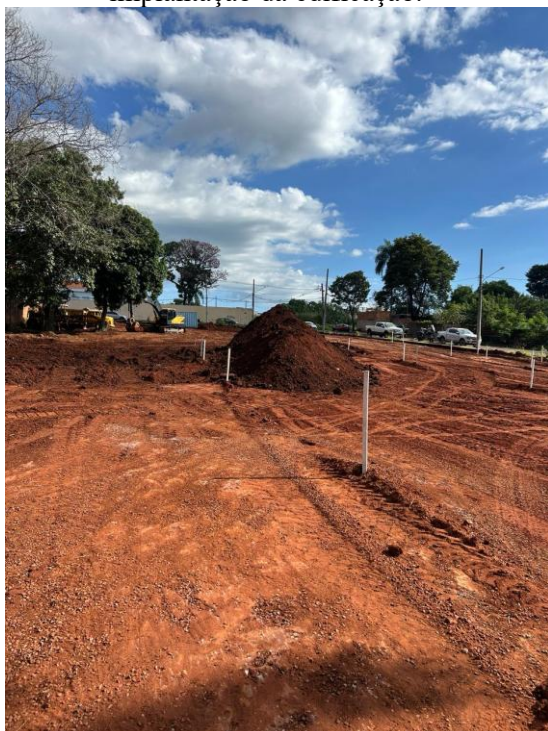
Figura 2 : Terraplanagem do lote para implantação da edificação.
