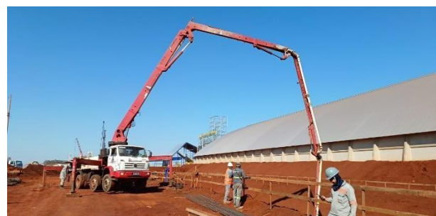
Figura 25 - Bomba lança 36 metros
