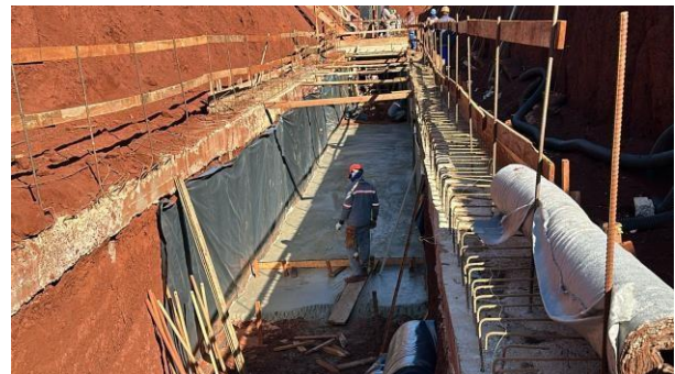
Figura 24 - Concretagem piso túnel
