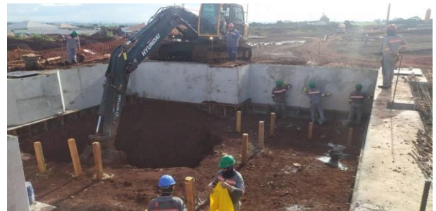
Figura 29 - Escavação poço de elevador
