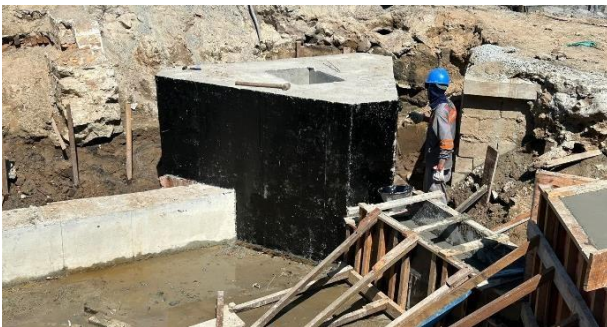
Figura 27 - Impermeabilização blocos de fundação
