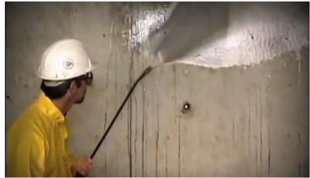
Figura 23 - Aplicação Xypex concentrado
