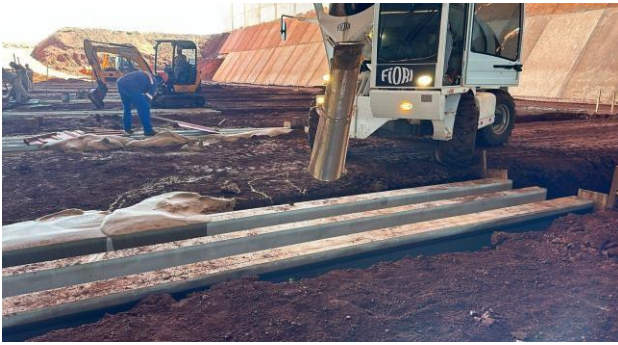
Figura 21 - Aplicação da argamassa de reaterro
