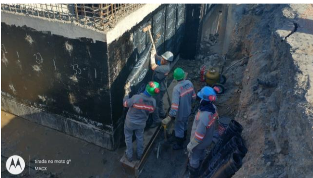
Figura 28 - Manta asfáltica em paredes
