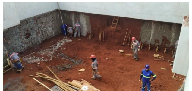
Figura 30 - Processo de chapisco
