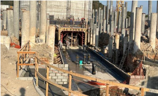
Figura 26 - Manta asfáltica em túnel
