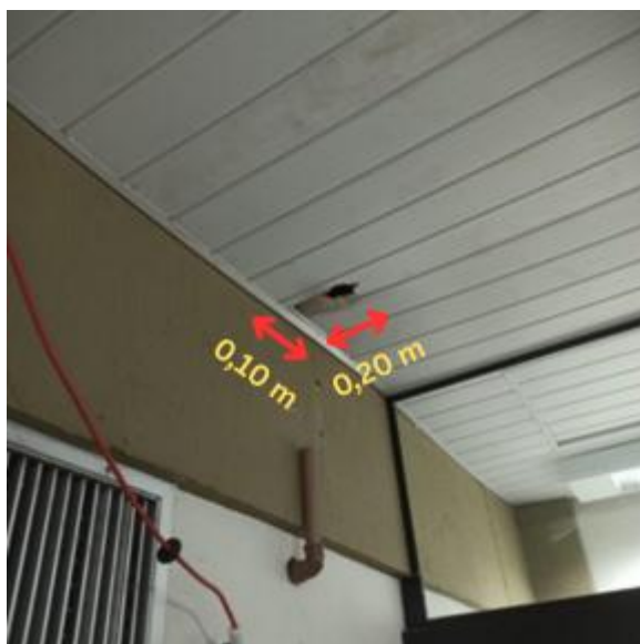
(c) Abertura do forro no corredor frio próximo do climatizador.
