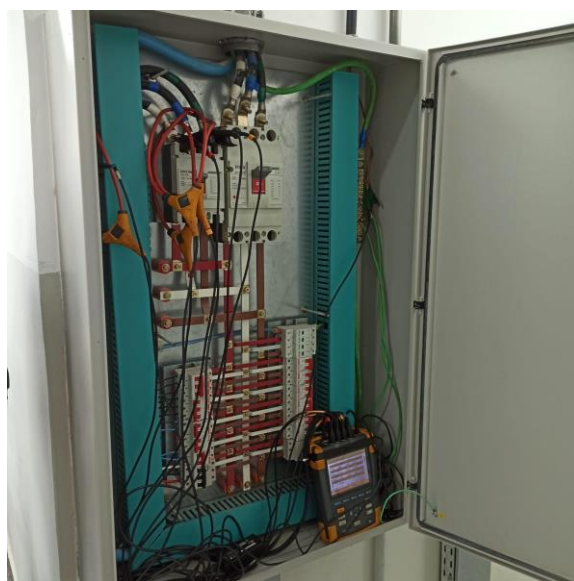
(b) Foto registrada da montagem do analisador de energia no quadro geral do DC.
