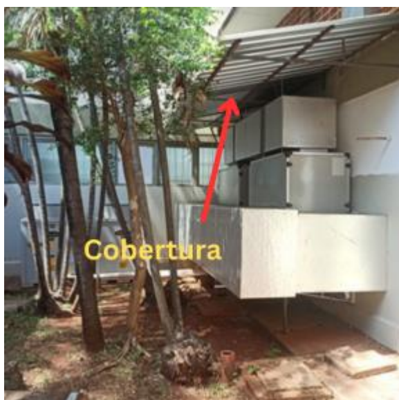
(g) Cobertura realizada para proteção e preservação do sistema central do ar do DC.
