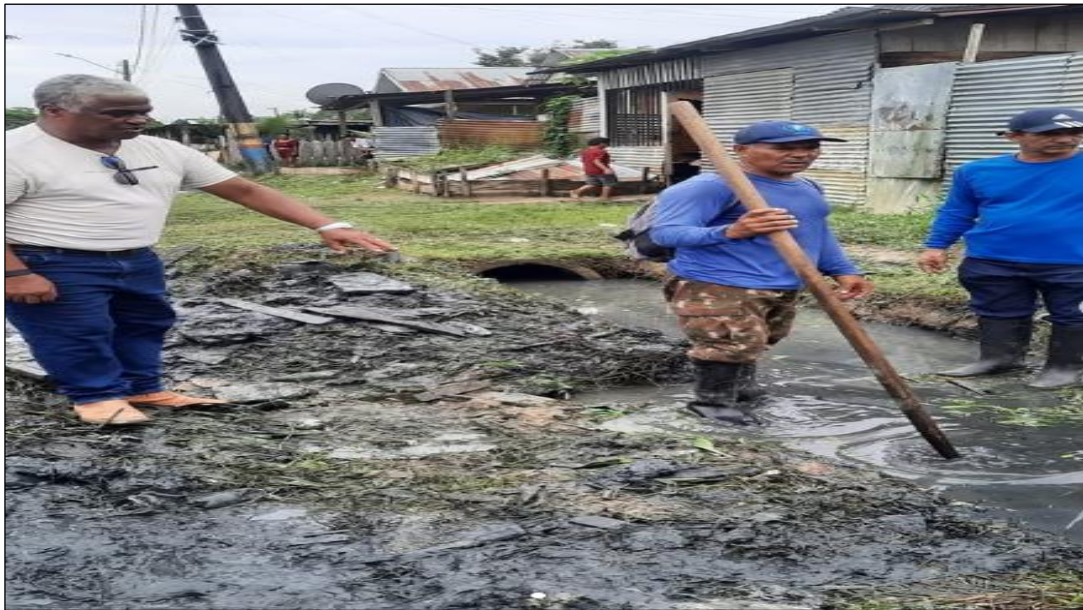
Figura 10 — Desobstrução da rede drenagem Fonte: Prefeitura Municipal de Tabatinga-AM
