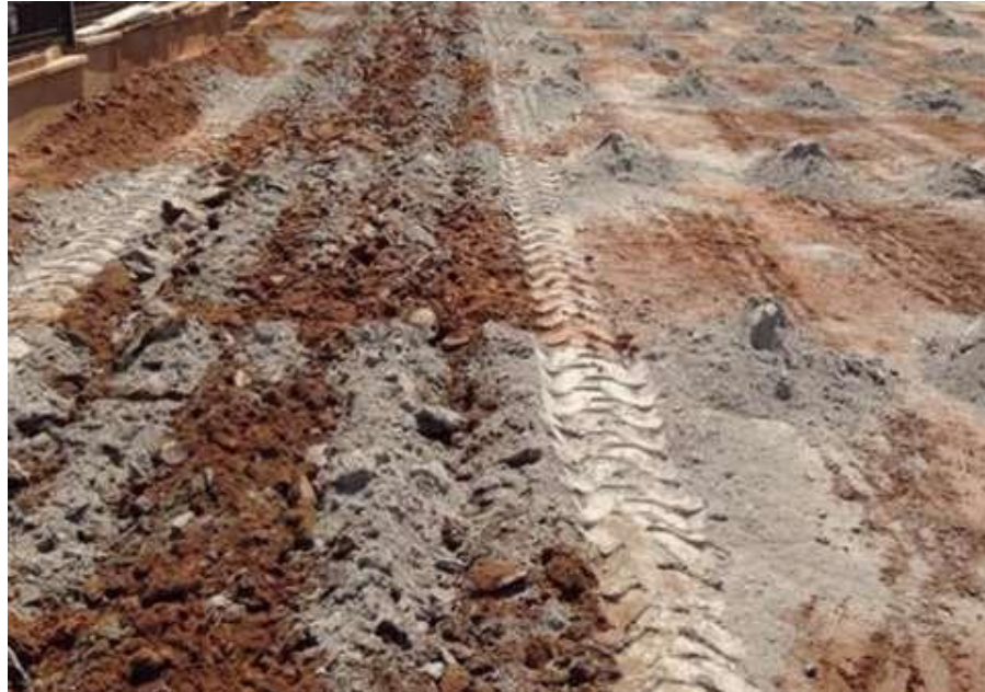
Figura 11. Solo-cimento utilizado na pavimentação – camada de base.
