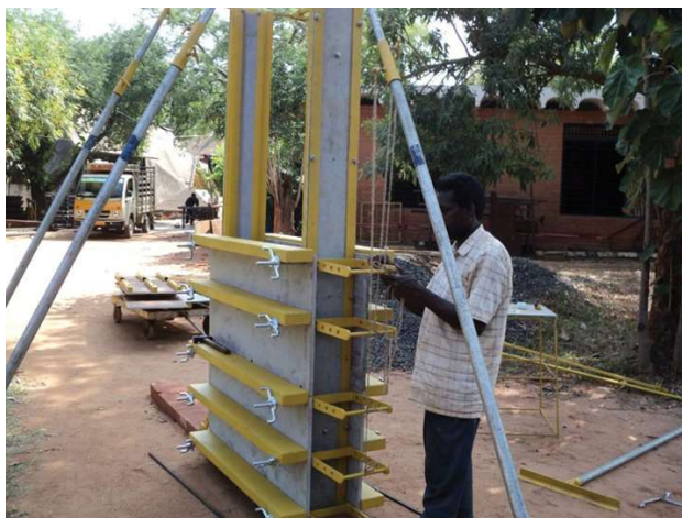
Figura 12. Fôrma travada por agulhas e escoras.
