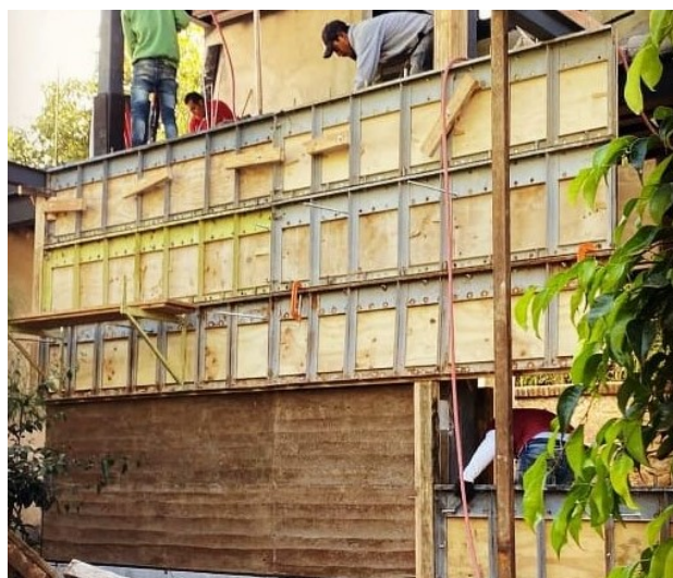
Figura 10. Fôrma contemporânea (placa de compensado e estrutura metálica)
