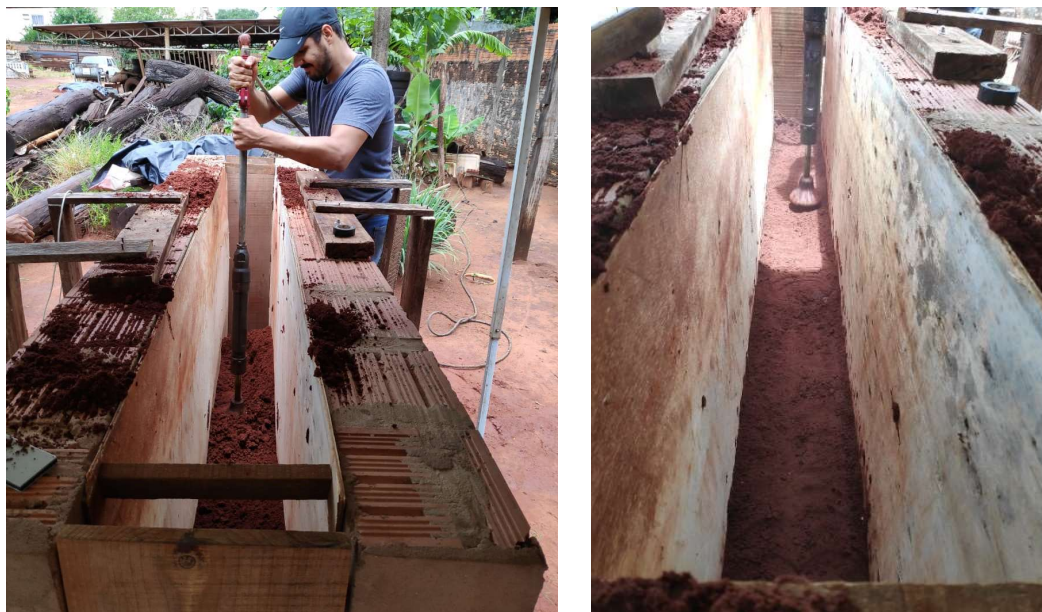
Figura 44. Compactação da mistura no molde indeformável.
