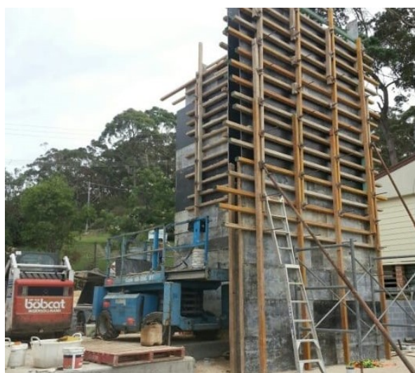
Figura 11. Fôrma contemporânea (estrutura em madeira e placa de compensado naval)
