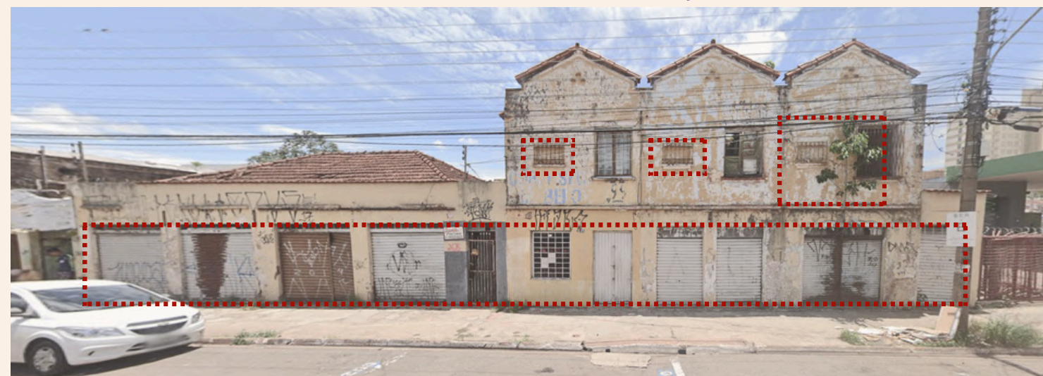
FIGURA 181: Fachada leste - Situação atual
