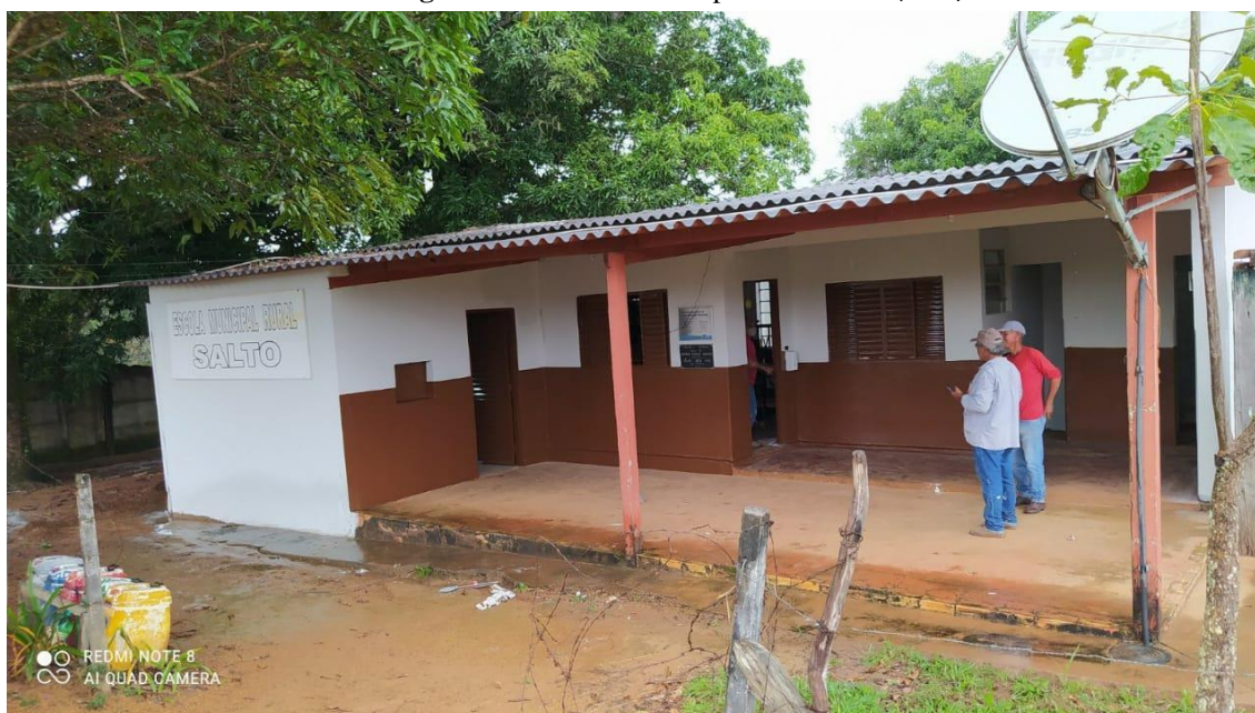
Figura 18 - Escola Municipal Rural Salto ( Jataí )
