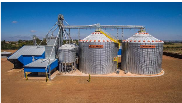
Figura 1 - Unidade armazenadora de grãos. Fonte: Kepler Weber
