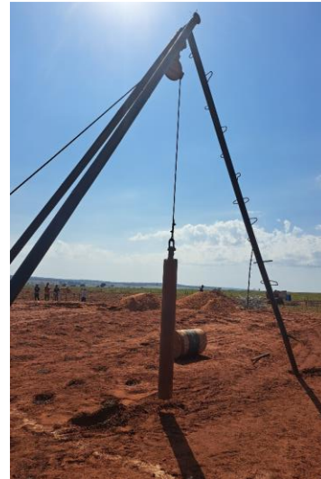
Figura 3 - Equipamento para vibro-compactação. Fonte: Solidifica Fundações
