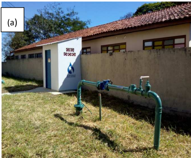
Figura 13 (a) e (b). Tubo camisa (EAT-003), abrigo e quadro de comando (EAT-003).
