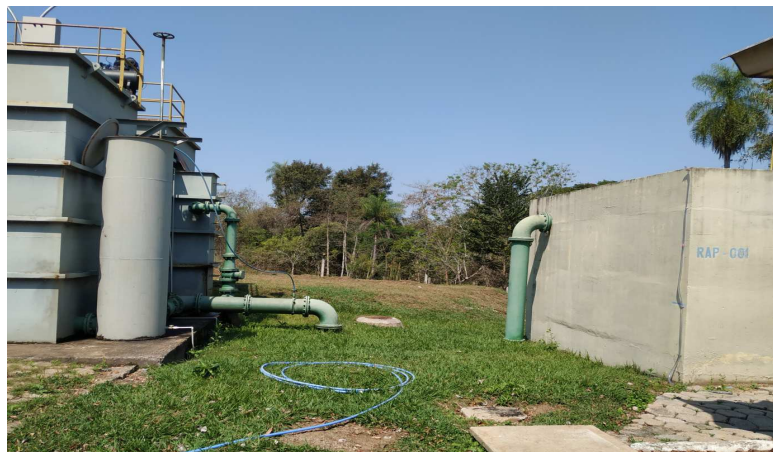
Figura 9. Estação de tratamento de água (ETA-001) e reservatório (RAP-003).
