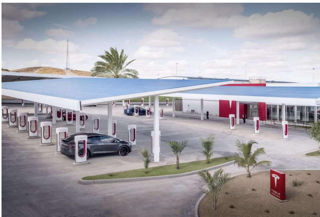
Figura 4 - Estação de recarga Supercharger da TESLA
