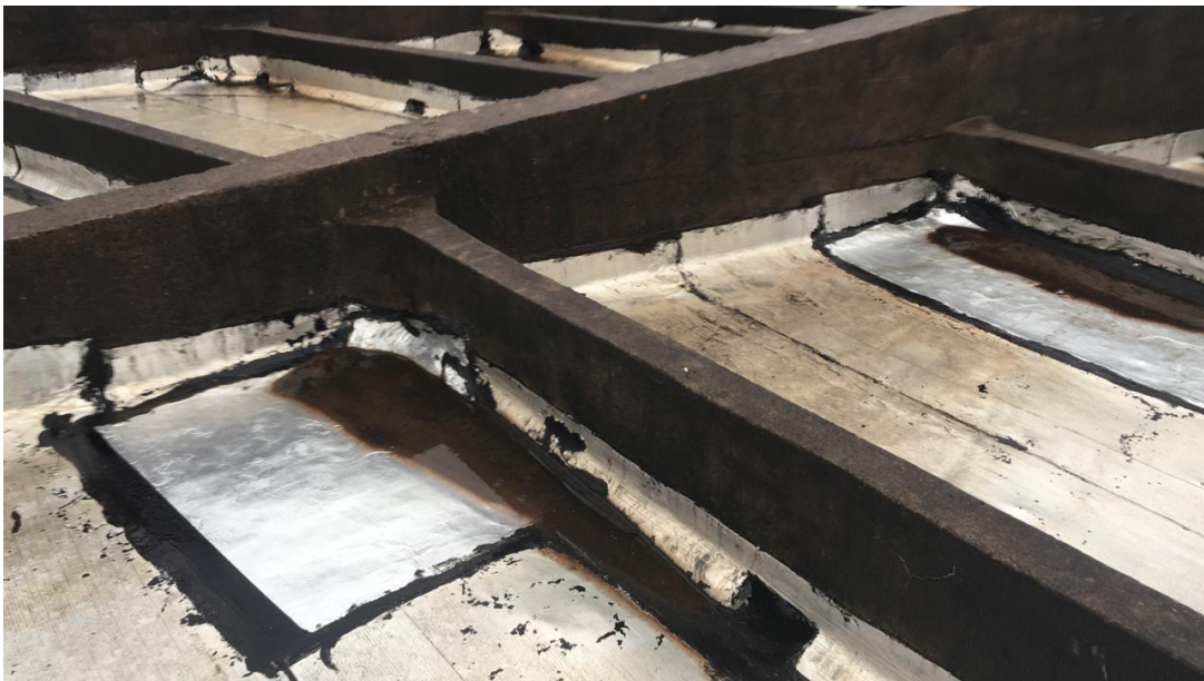
Figura 14. Material da cobertura do Estádio Pedro Pedrossian (Morenão)
