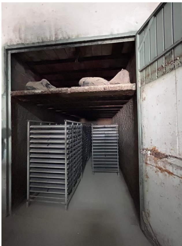
Figura 13 – Carrinhos de transporte com as telhas de concreto na estufa para período de cura inicial
