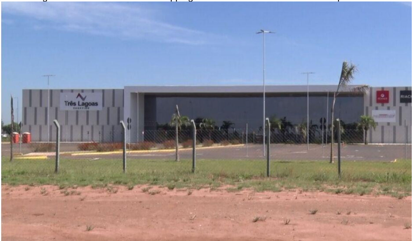
Figura 19 - Parte externa do shopping utilizada como estacionamento improvisado
