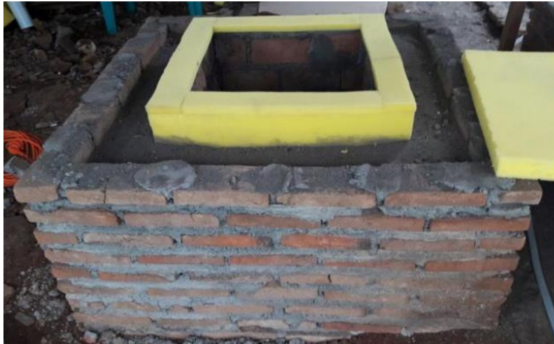
Figura 4 - Resfriador evaporativo em tijolo cerâmico construído por Dirpan et al (2018).
