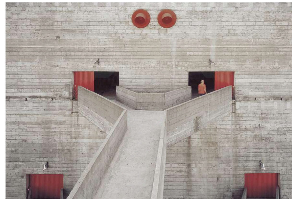
Figura 51 - Vista da passarela em Y.
