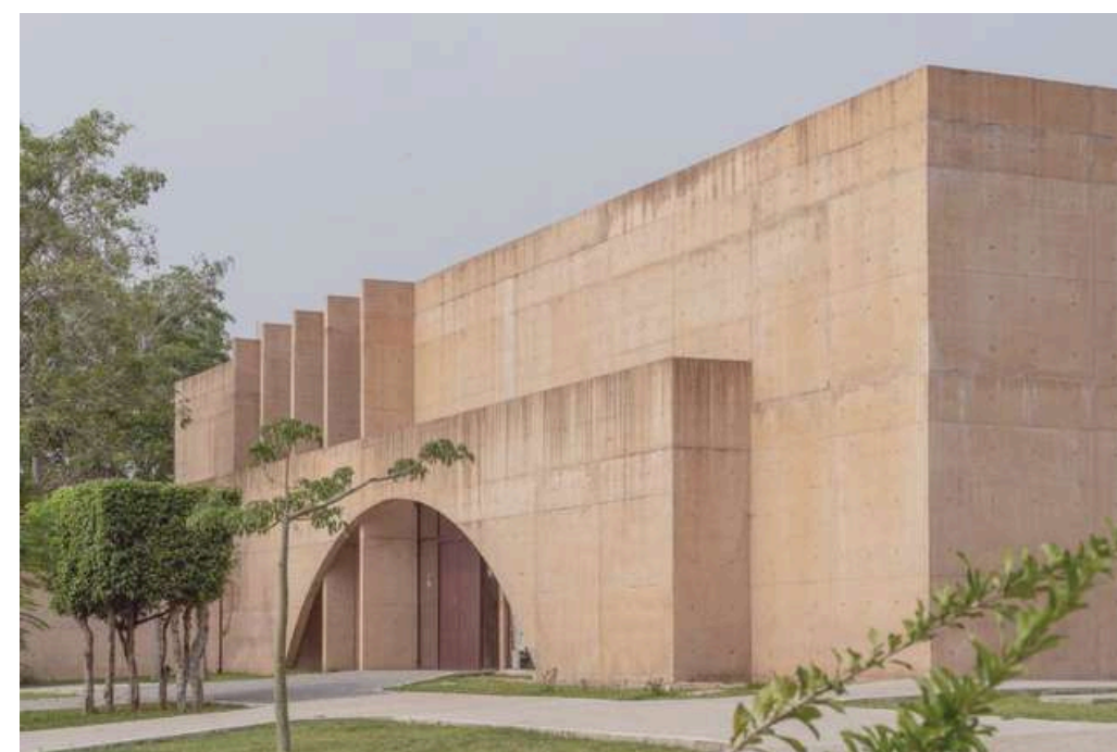
Figura 27 - Fachada do Centro de Desenvolvimento Comunitário.
