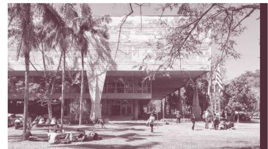
Figura 03 - Vista externa do edifício da FAU-USP.
