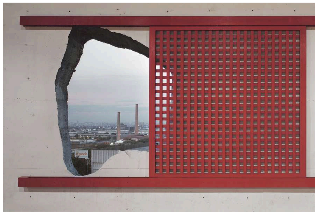
Figura 50 - Abertura irregular em parede de concreto no SESC Pompeia, utilizada como solução de ventilação natural.
