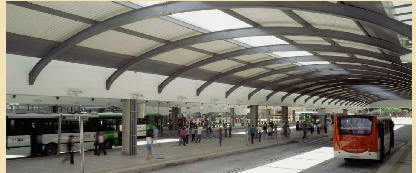
Figura 9 - Cobertura Metálica Iluminada
