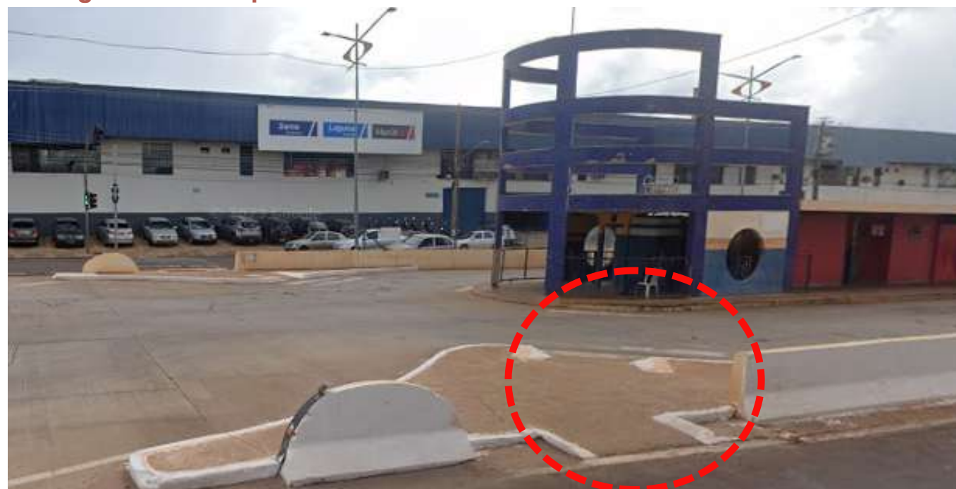
Figura 36 - Rampas de Acesso na Entrada Norte do Terminal Morenã
