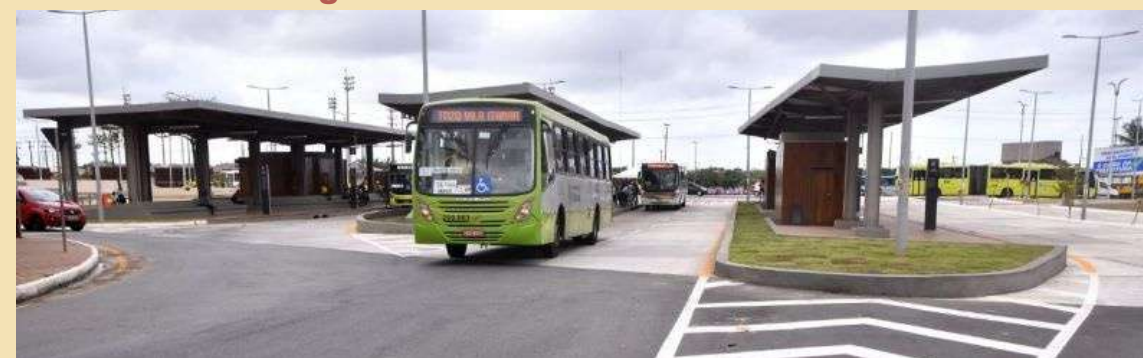
Figura 24 - Vista Saída do Terminal
