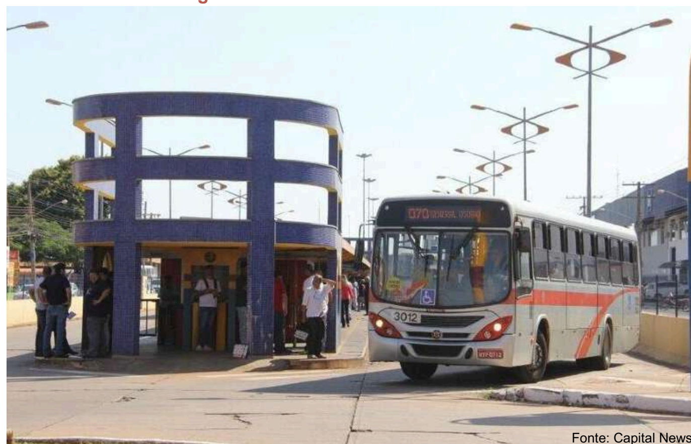
Figura 34 - Entrada Sul Terminal Morenã
