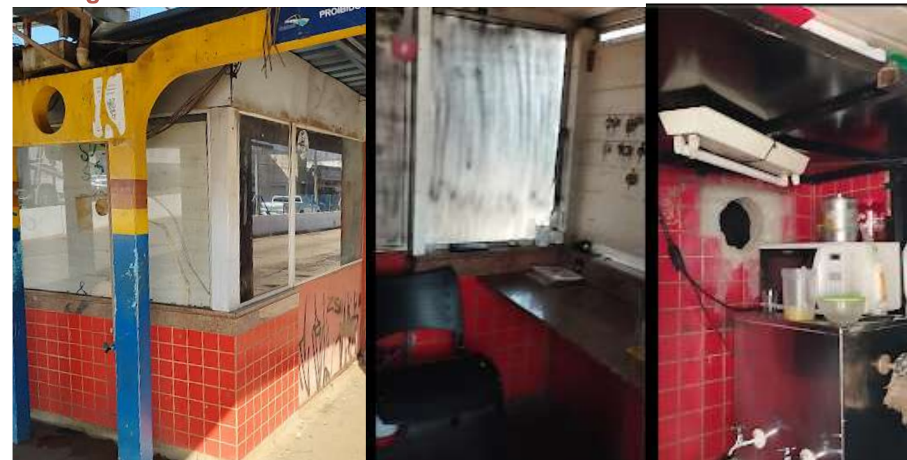
Figura 41 - Sala de Descanso dos Funcionários - Exterior e Interior
