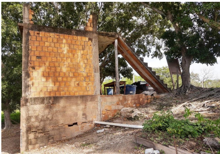
Figura 11. Fachada lateral da habitação alvo
