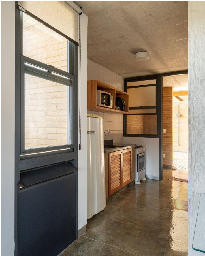
Figura 41. Porta ventilada e cozinha
