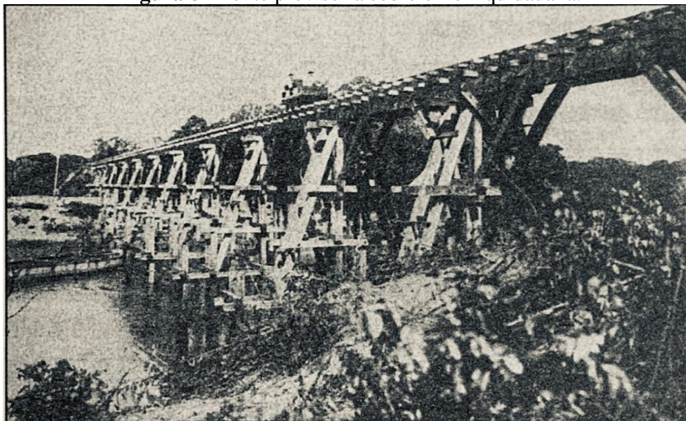
Figura 8 - Ponte provisória sobre o rio Aquidauana.
