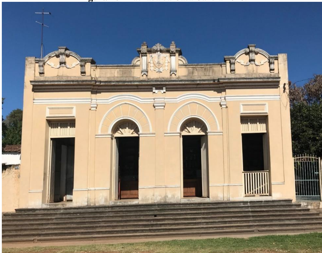
Figura 18 - Fachada da Casa Candia 2018.
