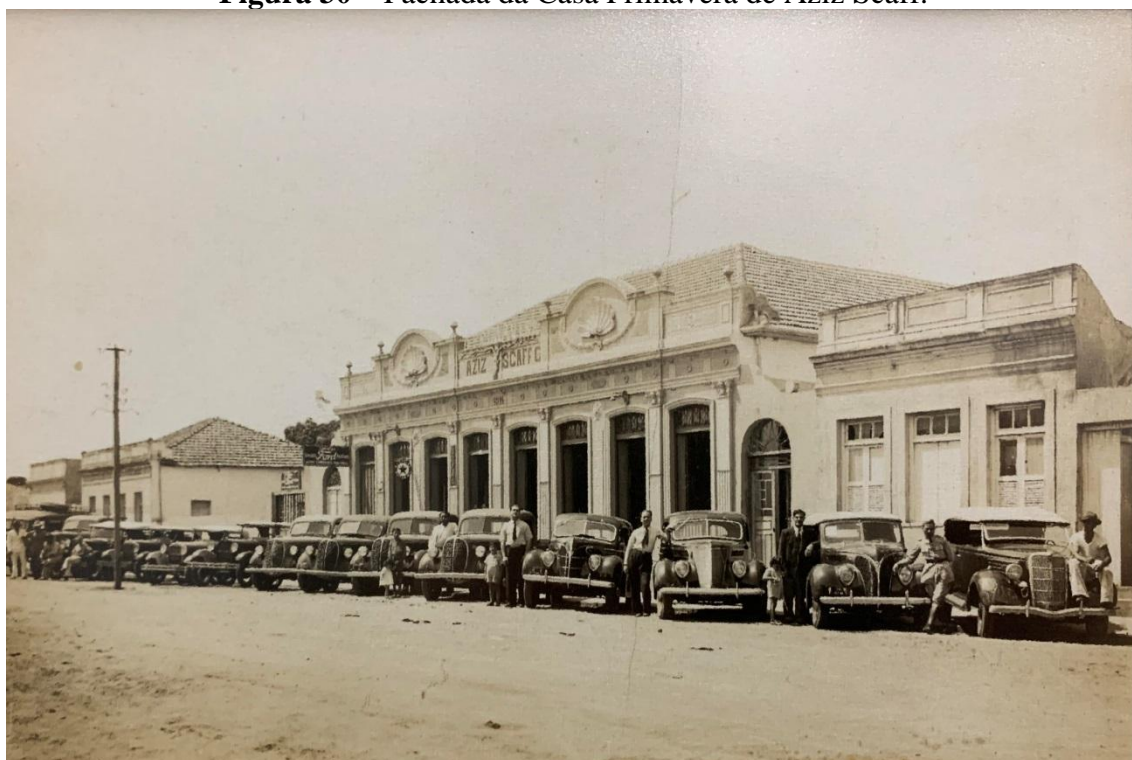
Figura 30 – Fachada da Casa Primavera de Aziz Scaff.
