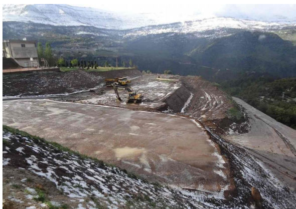
Figura 55: Construção da estrutura de entrada e saída do túnel de desvio de um rio
