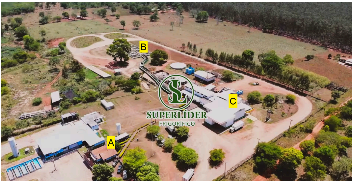
Figura 1: Vista aérea do Frigorífico Super Líder. Em destaque a portaria (A), os currais (B), área de manipulação dos produtos (C).
