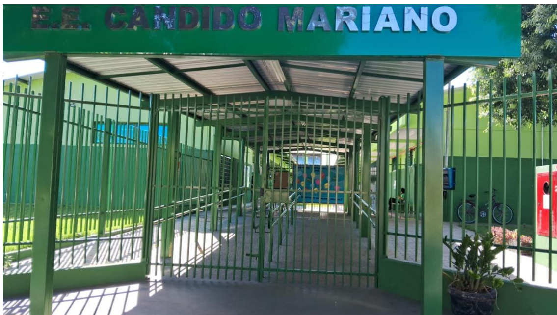
Figura 2: Entrada Principal da Escola Estadual Cândido Mariano.
