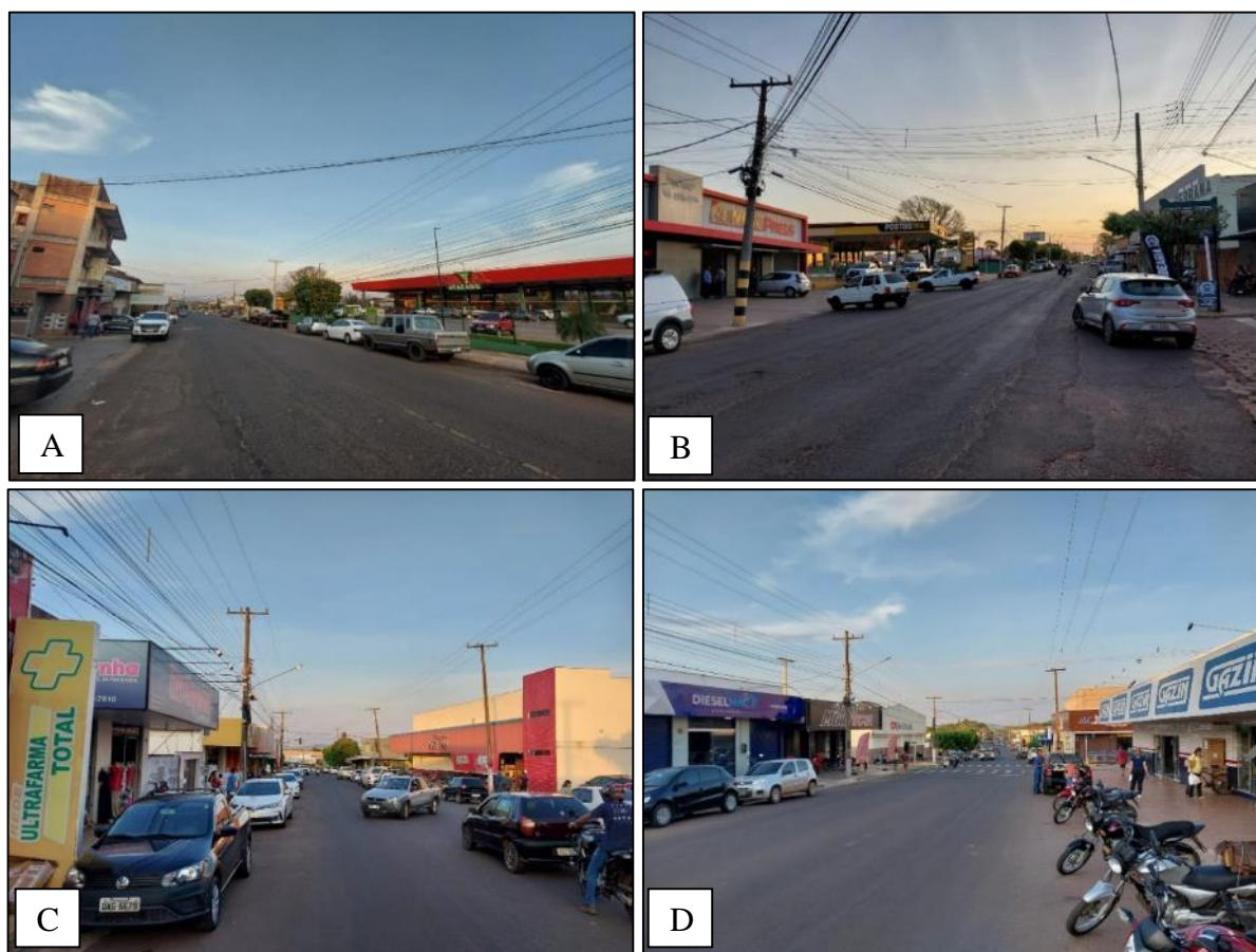
Figura 15 – Estrutura comercial na Avenida da Integração, Anastácio/MS.
