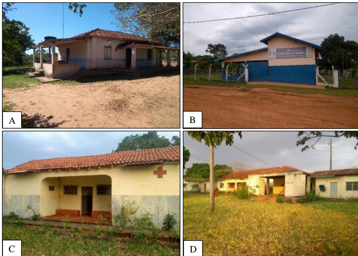
A) ESF Assentamento Indaiá III, Aquidauana/MS, (B) ESF Monjolinho, Ponto de Apoio Assentamento São Manoel, Anastácio/MS, (C e D) Respectivamente, Posto de Saúde da Colônia Paulista e Escola Municipal Rural Colônia Paulista Anastácio/MS, ambos desativados.
